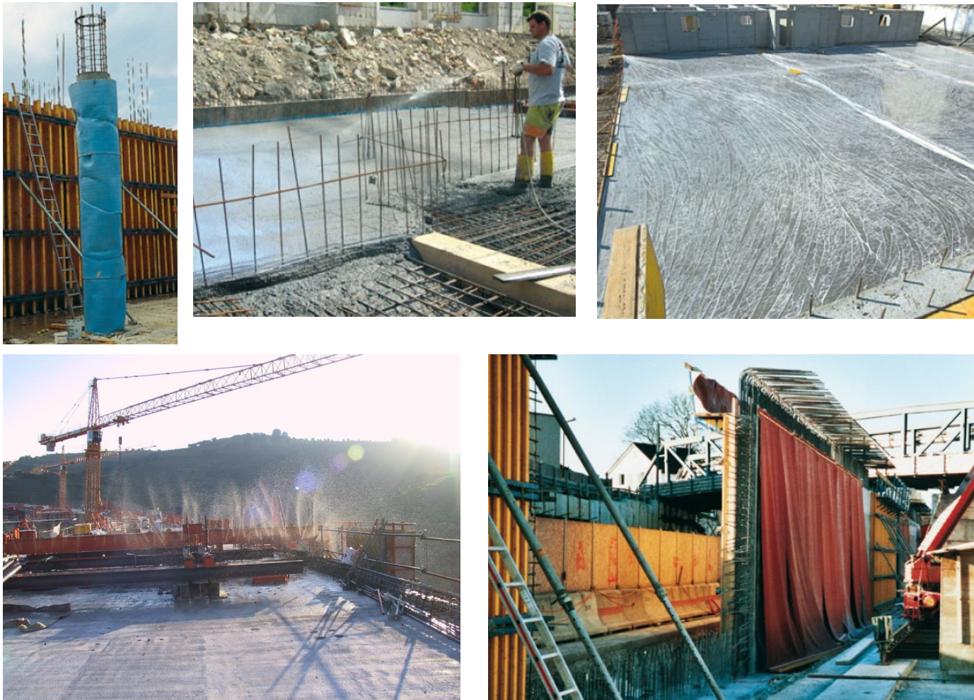
Figure 6.4 : exemple de cure à l'eau du tablier d'un pont (photo Eiffage).
